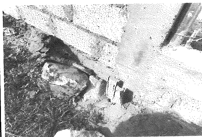
CIMIENTO AL AIRE POR MATERIAL SOCAVADO DEL RELLENO
